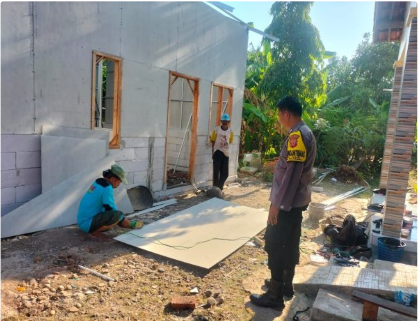
Bhabinkamtibmas Polsek Terisi Monitoring Pembangunan Rutilahu Dari Kapolres Indramayu.
